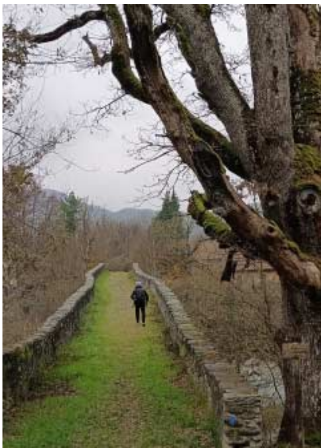
Ponte romano sul fiume Orba
