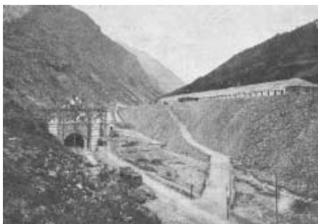
L'ingresso della galleria sul versante italiano - A destra la lunga tenda in cui il 17 settembre 1871 si tenne il banchetto inaugurale
