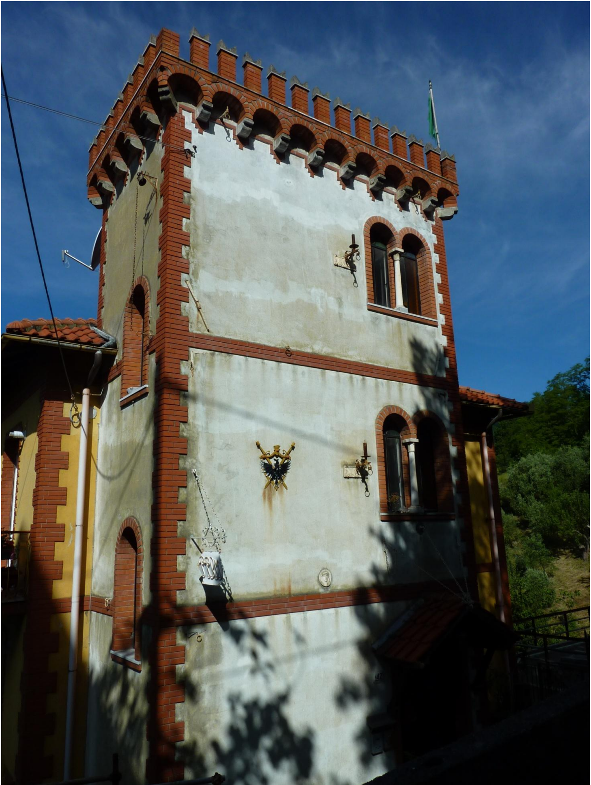
La casa con torre merlata in località Loixe .
