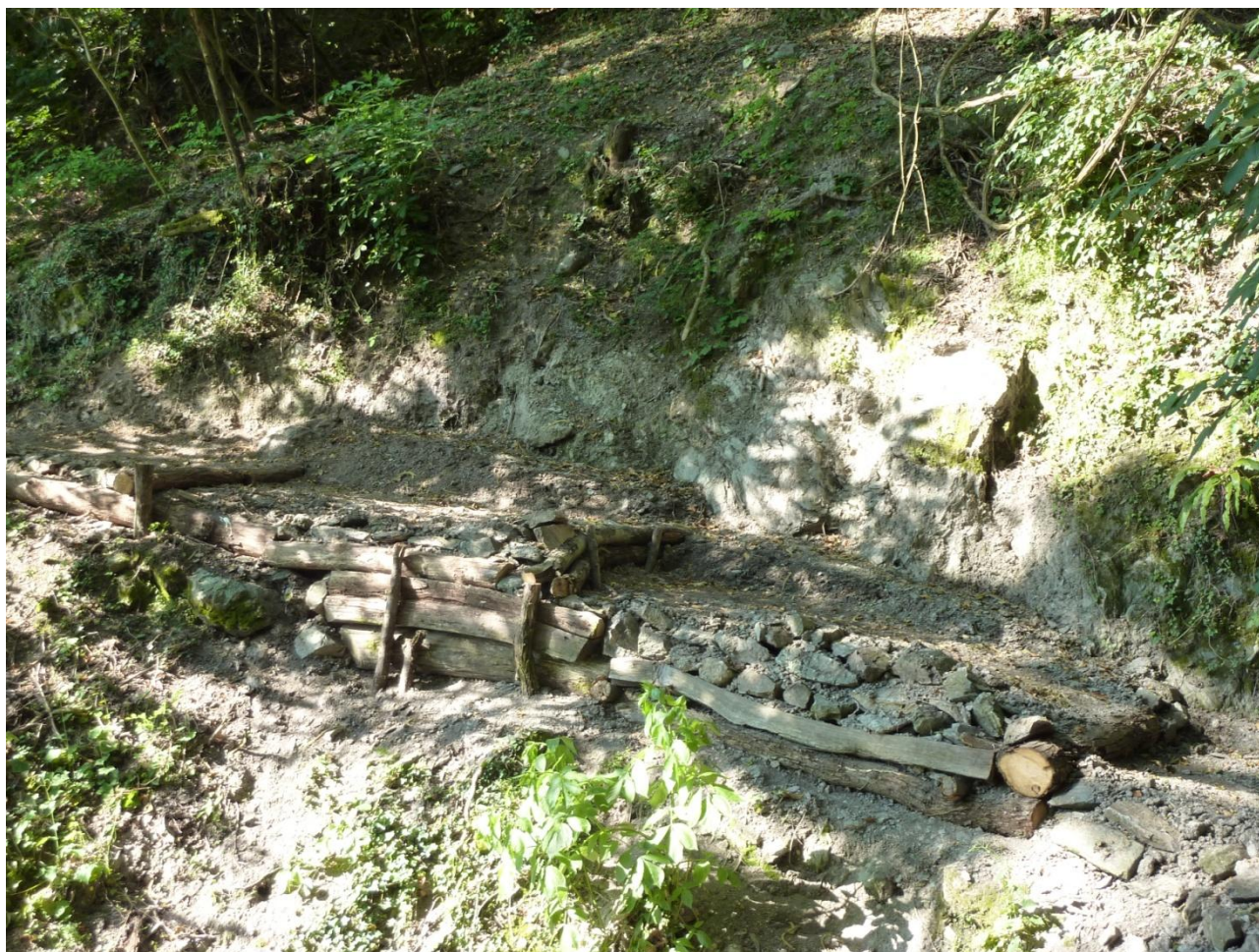
L'opera di ingegneria ambientale realizzata dal Gruppo Sentieri del CAI Bolzaneto per stabilizzare il versante destro del Riàn de Coétta .
